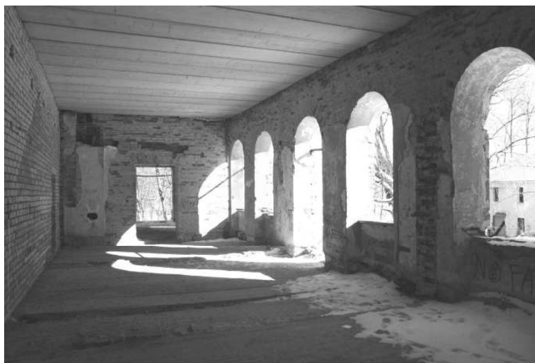
9. attēls. D puses telpas mūsdienas. Pa labi - izeja uz kādreizējo terasi virs verandas. Ārsienā redzamas izlauzto starpsienas. 20. gs. 80. gadu starpsiena un betona paneļu pārsegums (I. Dirveika foto).
