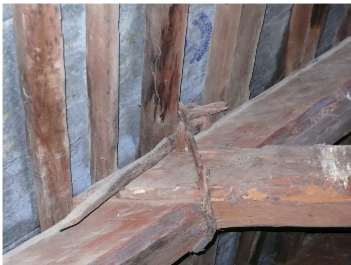
5. attēls. 19. gs. jumta konstrukcija. Spāre un saišķis sasieti ar kārklu klūgu. Latas pietapotas spārēm. 1930. gadu skārds „Emu Brand”. I. Dirveika foto (2011)
